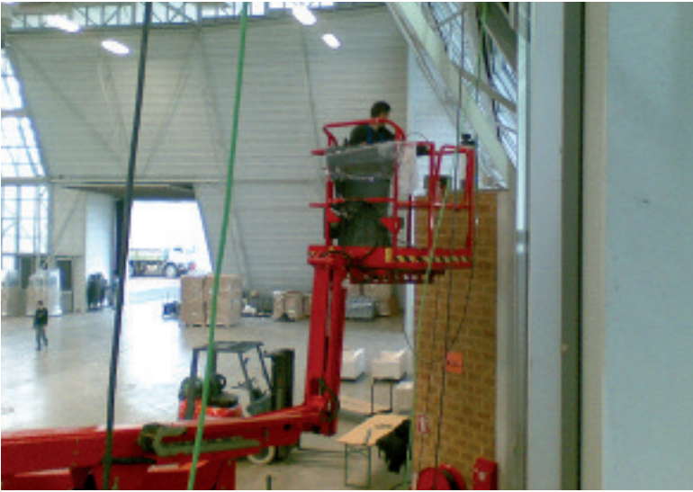
Installation du réseau informatique au Parc des Expositons à Chalon-sur-Saône ■
